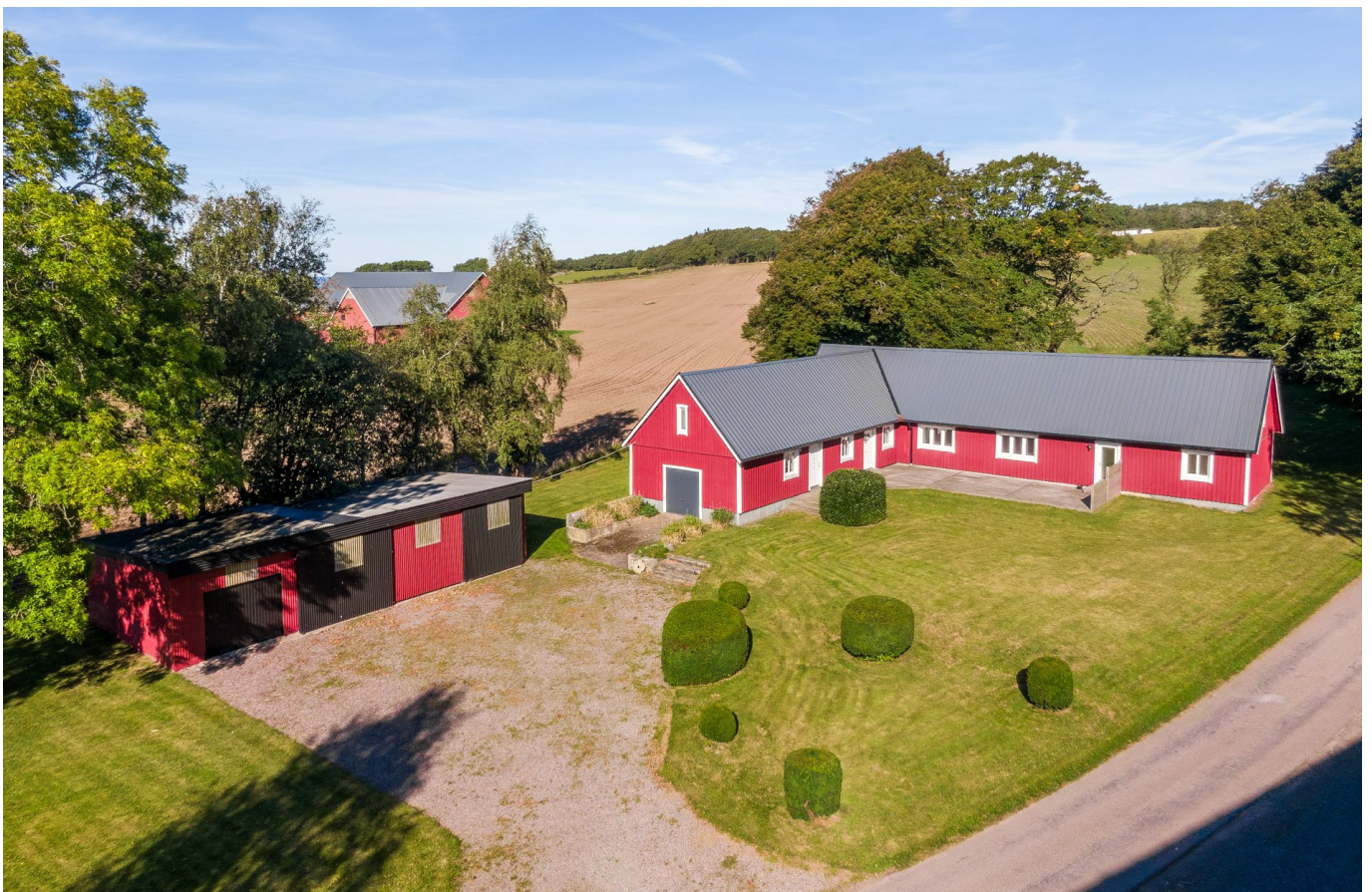
Förrådsdel vidbyggt bostaden
